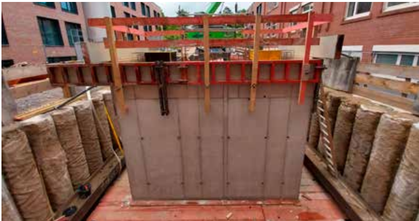
Fertigstellung der Pressgrube.
