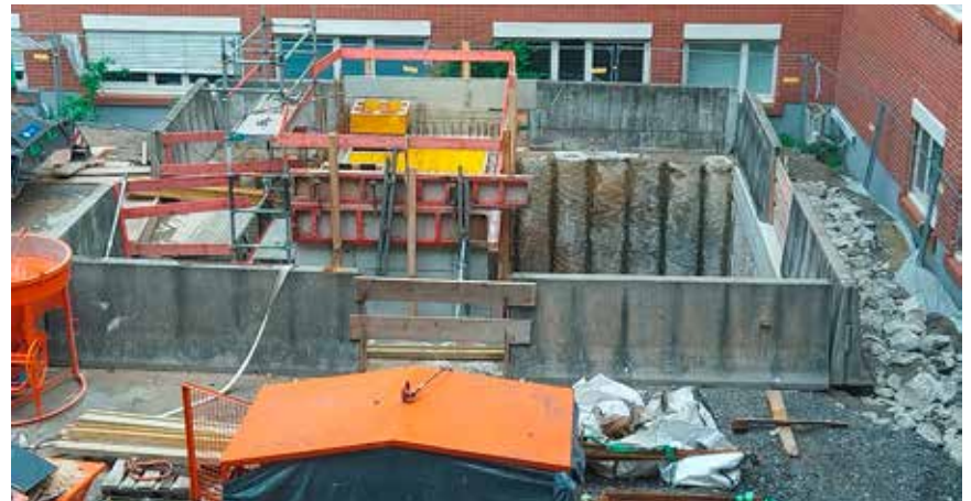
Pressgrube beinhaltet die Kabelschächte.
