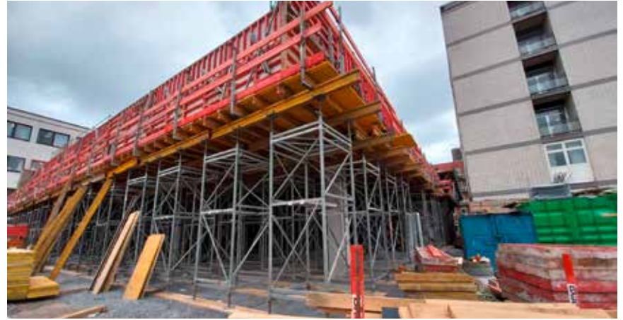
Betonierung der Decke über Ebene 01.
