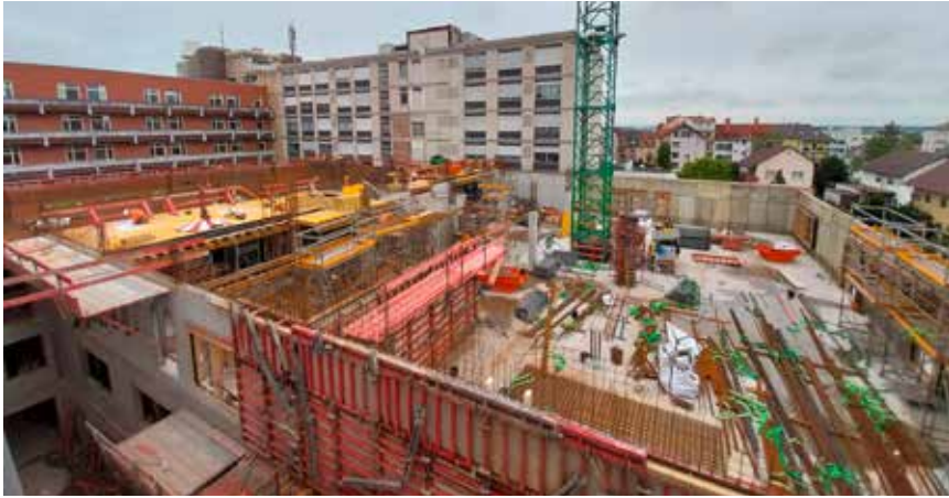
Der Rohbau geht schnell voran.
